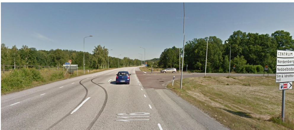
Riksväg 15 vid platsen för ny cirkulationsplats (sedd från söder) i korsningen mellan riksväg 15 och idrottsvägen från öster.
